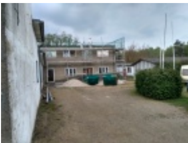
Sanierung unseres Vereinsheimes aktualisiert 18.05.2018
