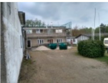
Sanierung unseres Vereinsheimes
