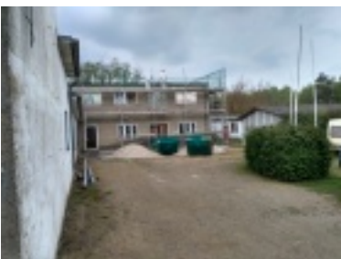
Sanierung unseres Vereinsheimes
