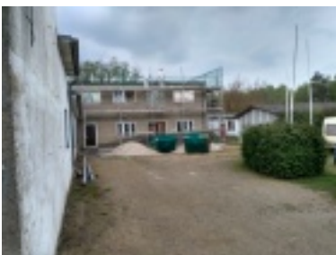
Sanierung unseres Vereinsheimes
